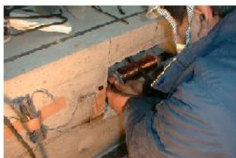
Site fabricated EM sensor
